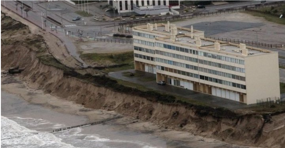
L'immeuble «Le Signal» à Soulac en Gironde (Source : © Journal Sud-Ouest)
