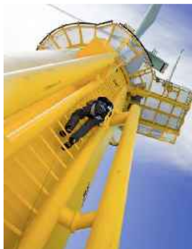
Figure 39 – Accès à la turbine par la pièce de transition (source DONG Energy)
