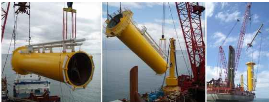
Figure 15 – Basculement de la pièce de transition pour la mise à l'eau (source DONG Energy)
