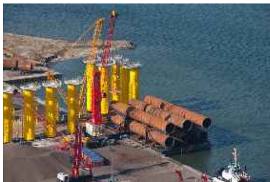
Figure 13 – Monopieux placés sur barge (source DONG Energy)
