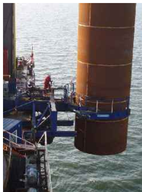
Figure 14 – Descente du monopieu dans son guide (source DONG Energy)
