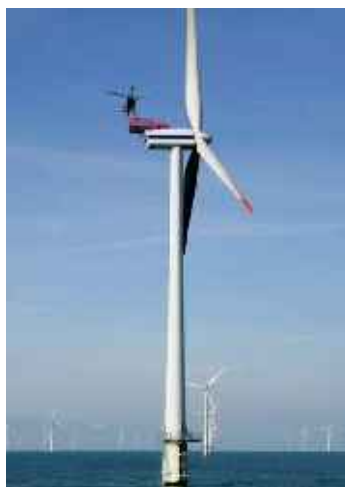
Figure 38 – Hélicoptère sur le site d'Horns Rev (source DONG Energy)
