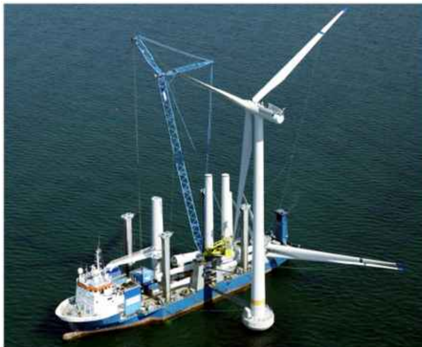
Figure 22 – Navire d’installation après montage d’un aérogénérateur (source A2SEA)
