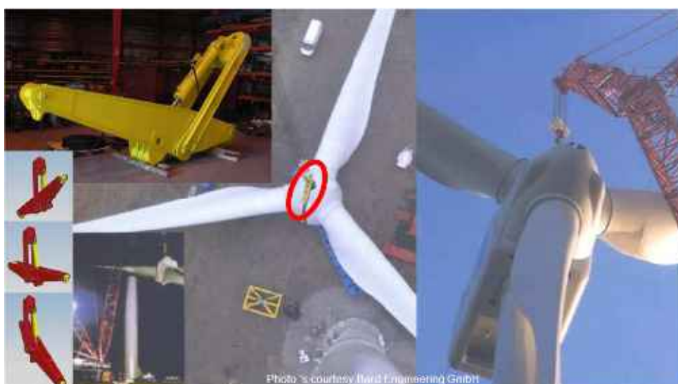
Figure 21 – Outil de basculement du rotor, de 165 Tonnes de capacité (source Gusto MSC)
