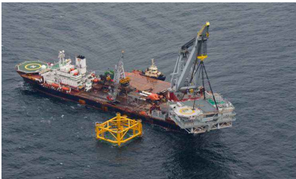
Figure 18 – Installation d'une sous-station (source DONG Energy)
