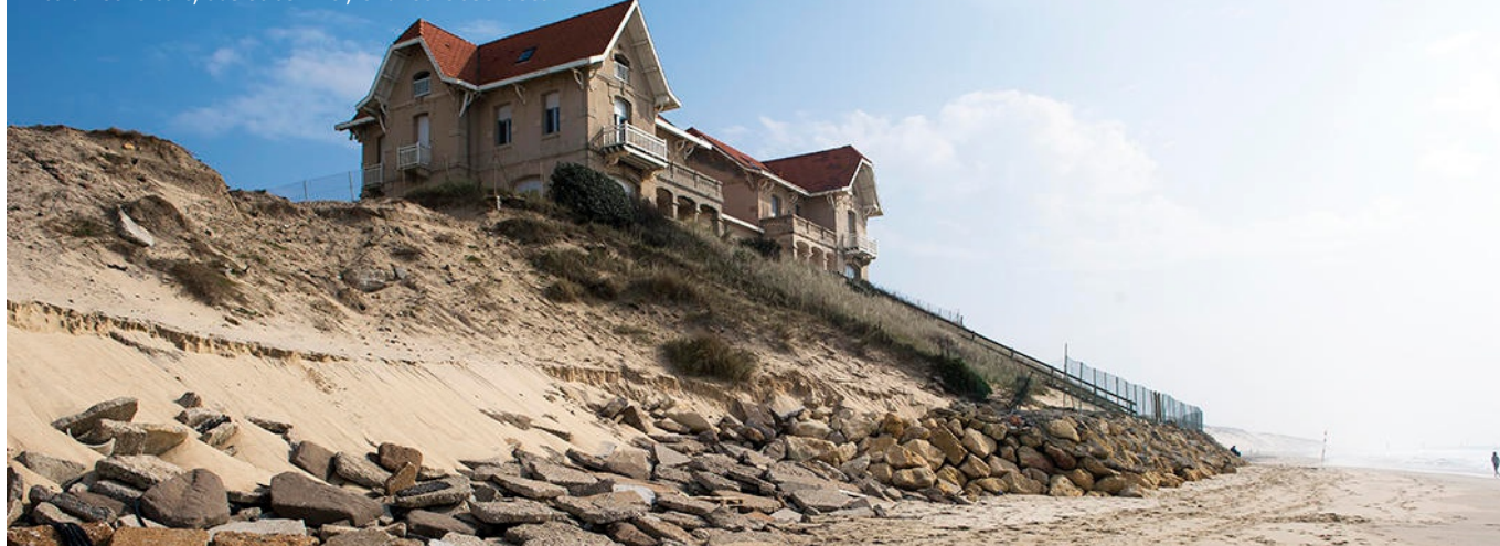
Érosion de la côte, Soulac-sur-Mer, Gironde ©Sud-Ouest
