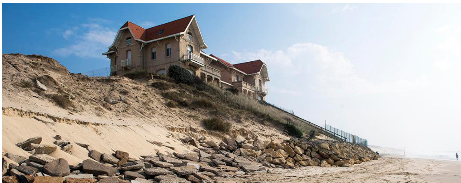
Erosion de la côte, Soulac-sur-Mer, Gironde ©Sud-Ouest
