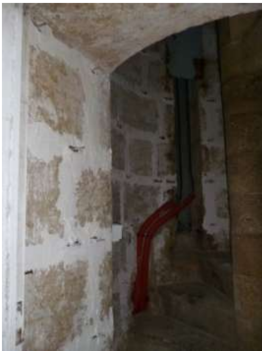
Fissures et joints cachetés (2/2)
