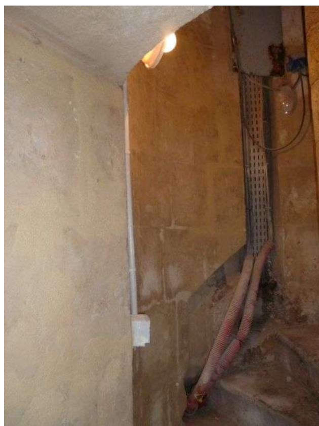
Rejointoiement au mortier à chaux à l'intérieur
