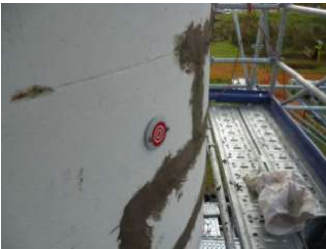
Cible posée sur l'ouvrage
