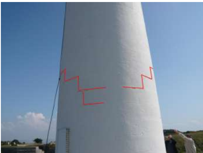
Schéma de fissuration sur la face ONO
