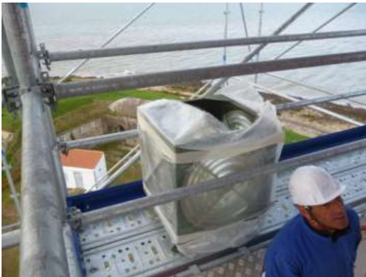
Dépose de l'optique
