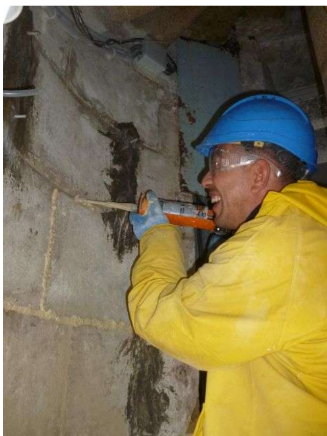
Rejointoiement au mortier à chaux à l'intérieur
