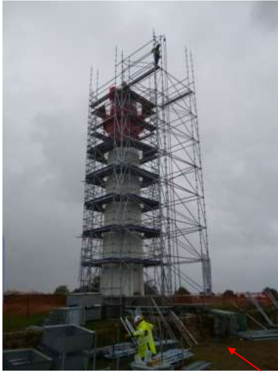
Fin du montage de l'échafaudage
