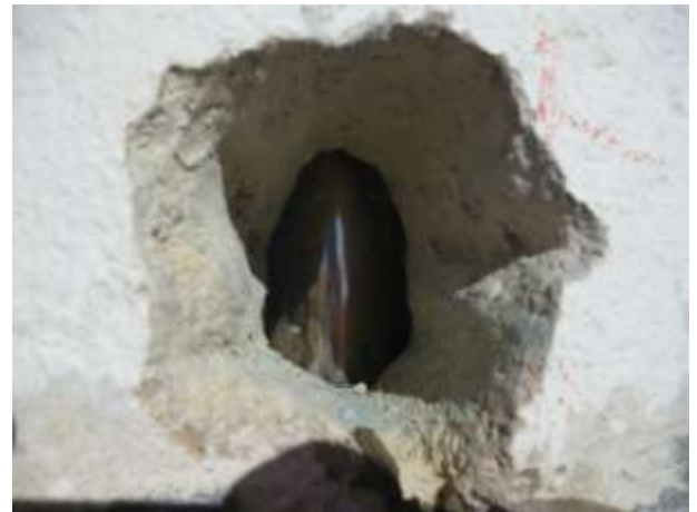
Vue du tirant à 15 cm du bord extérieur de l'ouvrage
