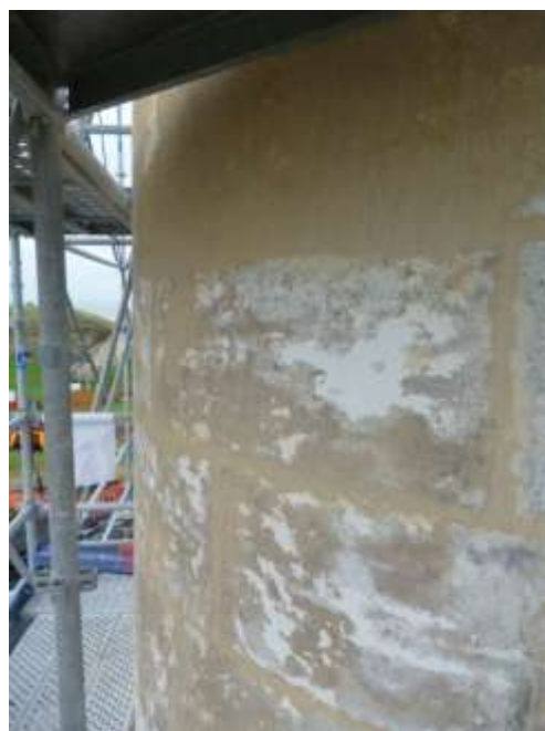
Rejointoiement au mortier à chaux à l'extérieur
