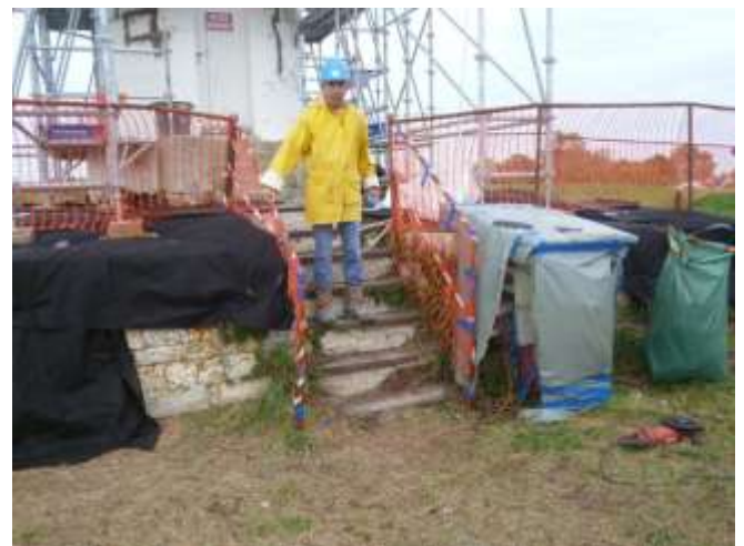
Accès à l'échafaudage
