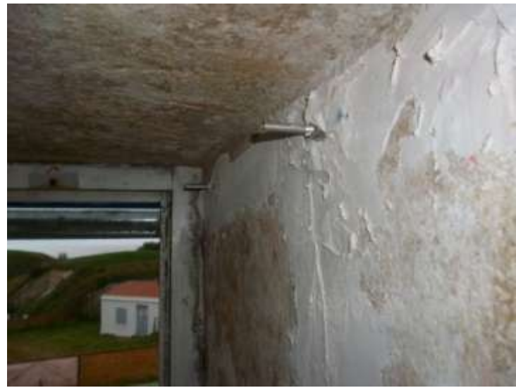
Fissures et joints cachetés (1/2)
