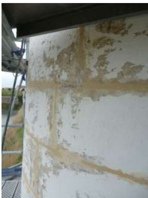
Rejointoiement au mortier à chaux à l'extérieur
