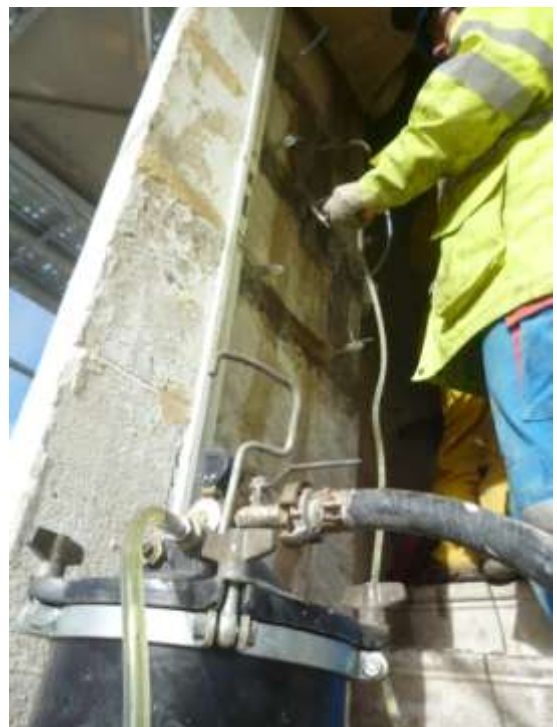
Injection de la résine sous pression
