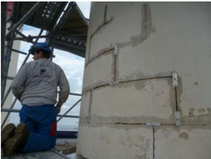
Mise en place des évents
