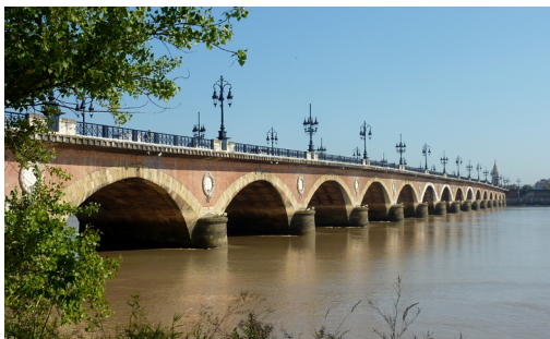
Pont de Pierre à Bordeaux (Source : Les Énergies de la Lune)
